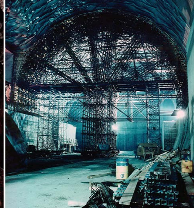
Großbaustelle Plabutsch: Der steirische Tunnel ist bis heute der zweitlängste zweiröhrige Straßentunnel Europas
