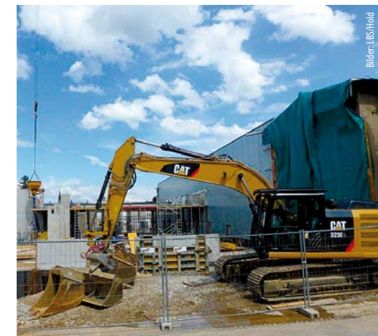
Bagger und Kran sind im Dauereinsatz auf dem Areal des Berufsschulzentrums in Graz-St. Peter.
