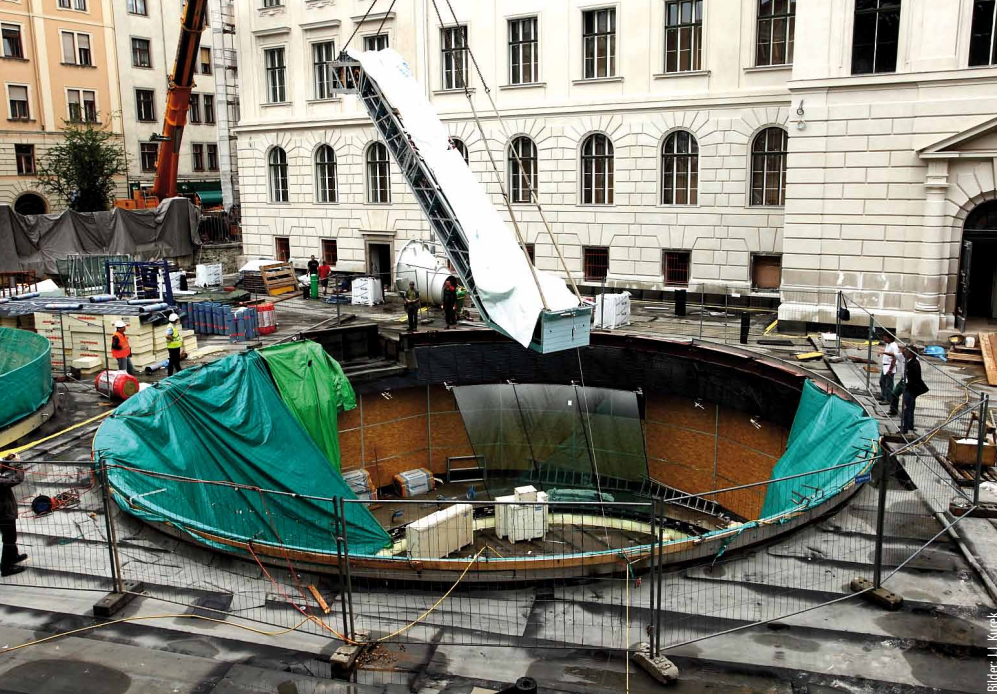
In der Zielgeraden: Die Bauarbeiten für das Joanneumsviertel
