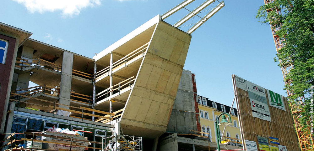
Der Zu- und Umbau der Tourismusschulen Bad Gleichenberg geht in die Zielgerade.
