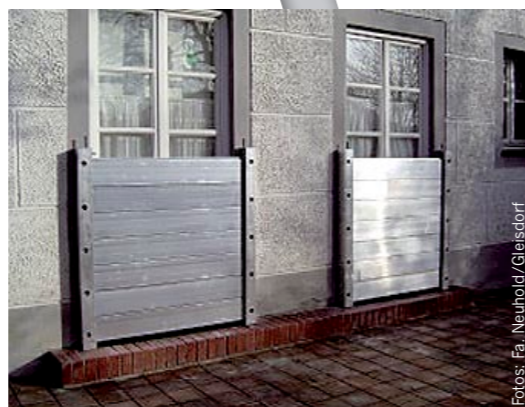
Die mobilen Schutzelemente werden im Notfall in die fix montierten Halterungen schnell und einfach eingesetzt.
