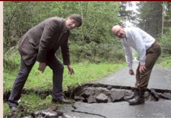
Ein rutschender Hang als Überbleibsel der starken Regenfälle: BH Mag. Hannes Peißl und Katastrophenschutzreferent Artur Holawat begutachten eine Hofzufahrt.
