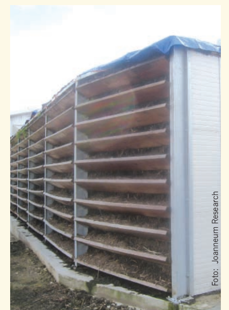
Die erste Biofilteranlage in Groß St. Florian
