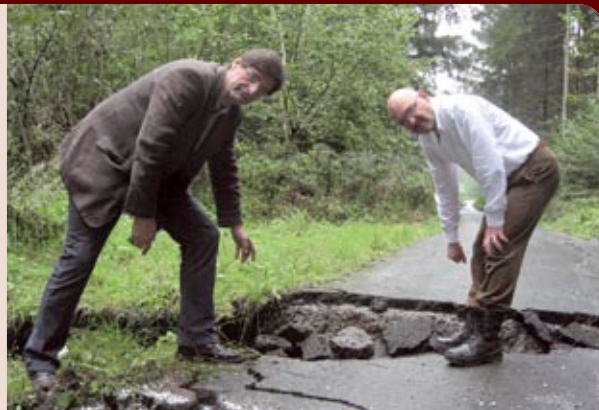
Ein rutschender Hang als Überbleibsel der starken Regenfälle: BH Mag. Hannes Peißl und Katastrophenschutzreferent Artur Holawat begutachten eine Hofzufahrt.
