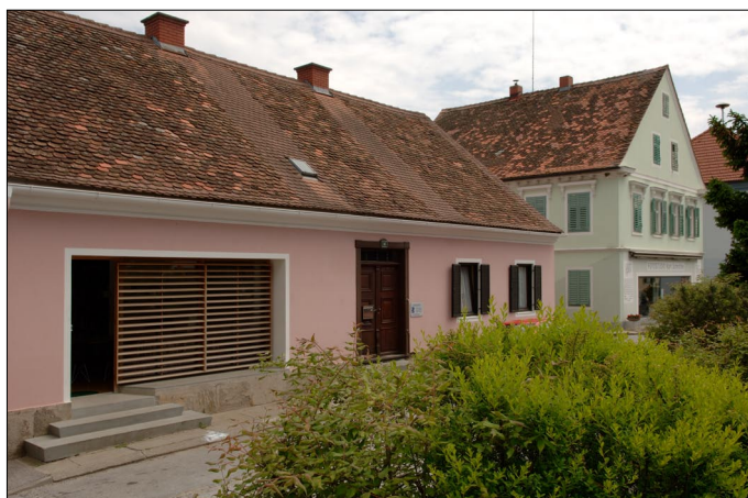
Bürohaus Seeger, Kumberg Planung: Arch. Dipl.-Ing. Guido Seeger, Kumberg Bauherr: Georg Loder, Kumberg
