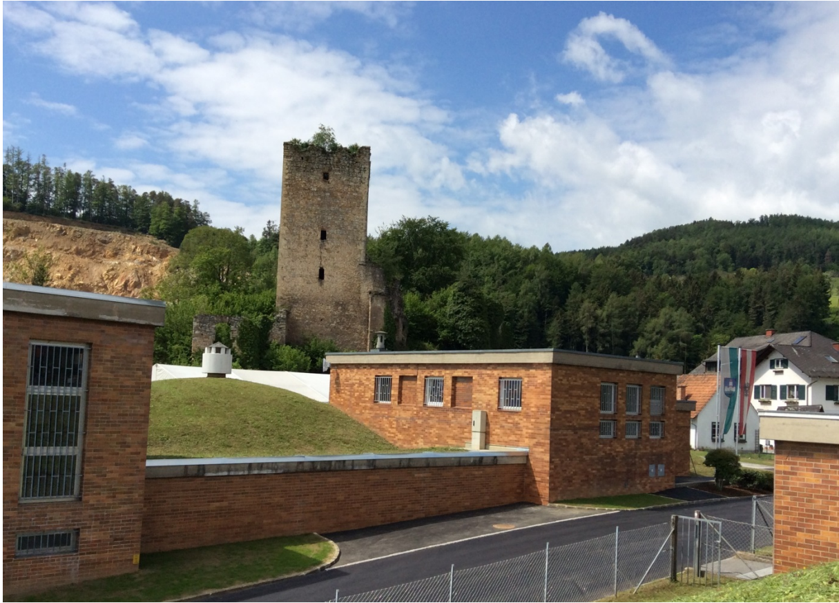
Wasserversorgungsanlage in Sturmburg
