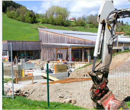
Im nunmehrigen Ortsteil Eppenstein wird eine neue Kinderkrippe gebaut.
