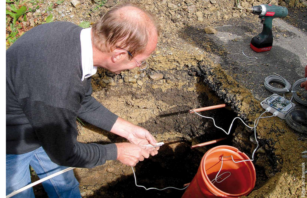
Die Messung der Straßenbelagstemperatur erfolgt in mehreren Schichten – die Messdaten werden mit jenen für die Außentemperatur kombiniert.
