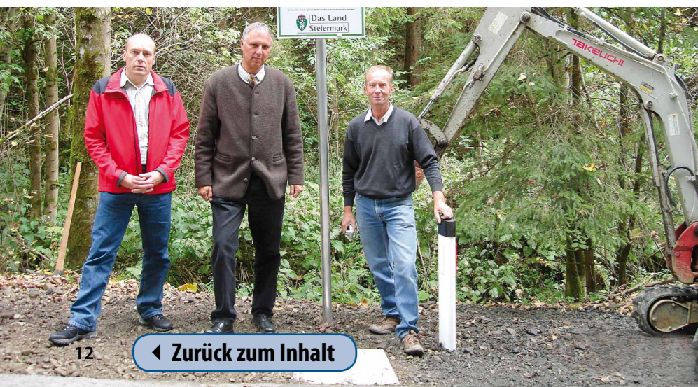
Karl-Heinz Paier, Klaus Sauermoser (Leiter der FA18D), Josef Luttenberger (v. l.) bei einer der fertiggestellten Messstationen für die Belagstemperatur.
