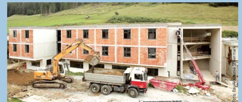
Die Arbeiten zur Errichtung des Bauwirtschaftslehrlingsheims sind voll im Gang.
