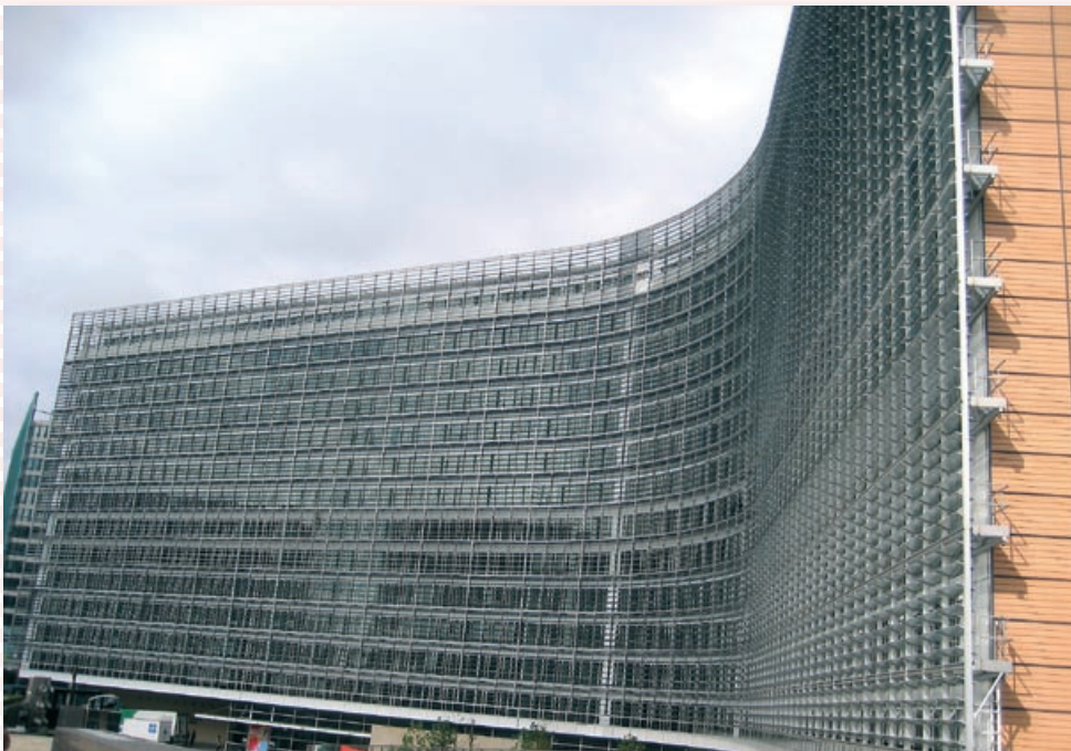
Das Berlaymont-Gebäude als eines der Zentren der Europäischen Union. Bis vor wenigen Jahren stand von diesem Gebäude nur das Stahlbeton-Skelett, da es wegen des darin verbautes Asbestes nahezu vollkommen ausgehöhlt werden musste. Seit drei Jahren ist das Haus wieder voll in Betrieb und mit exquisiter Technik ausgestattet: Computer gesteuerte Jalousien regeln den Wärmebedarf, Regenwasserkollektoren am Dach liefern Spülwasser für die WC's.
