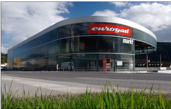
Eurogast Landmarkt, Liezen – Planung: Egger-Kreiner, Architekten ZT-GmbH: Eine Markthalle, die mit ihrer klaren und ruhigen Gestaltung in die Zukunft weist. Ummantelt ist sie von einer Profilitverglasung, die Licht hinein lässt, gleichzeitig aber den Lärm fernhält.
