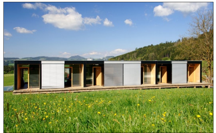
Jugendcamp Passail – Planung: HolzBox (Tirol): „Da ist einfach die Frage, ob man eine Symphonie oder den Musikantenstadl hören will..“, so Architekt Ferdinand Reiter von HolzBox. Eine moderne und zugleich zeitlose Architektur für ein multifunktionales Jugendcamp.
