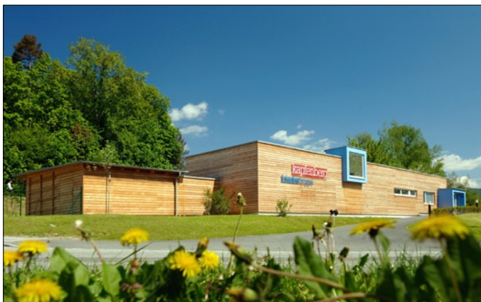
Kinderkrippe Töllergraben, Kapfenberg – Architekten: Andexer&Moosgruber: Raffinierte Details charakterisieren die U-förmig gebaute Kinderkrippe mit ruhigem Innenhof, dem auch die großen Fensterflächen zugewandt sind. Außen ist die Kinderkrippe durch die kompakt gestaltete Holzfassade geschützt.
